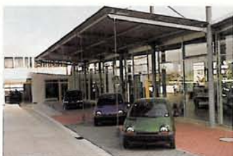
Schnitt durch die Ausstellungshalle: Wie zwei parallel gestellte Bahnsteigüberdachungen wirkt die abgehängte und abgespannte Stahlkonstruktion.
