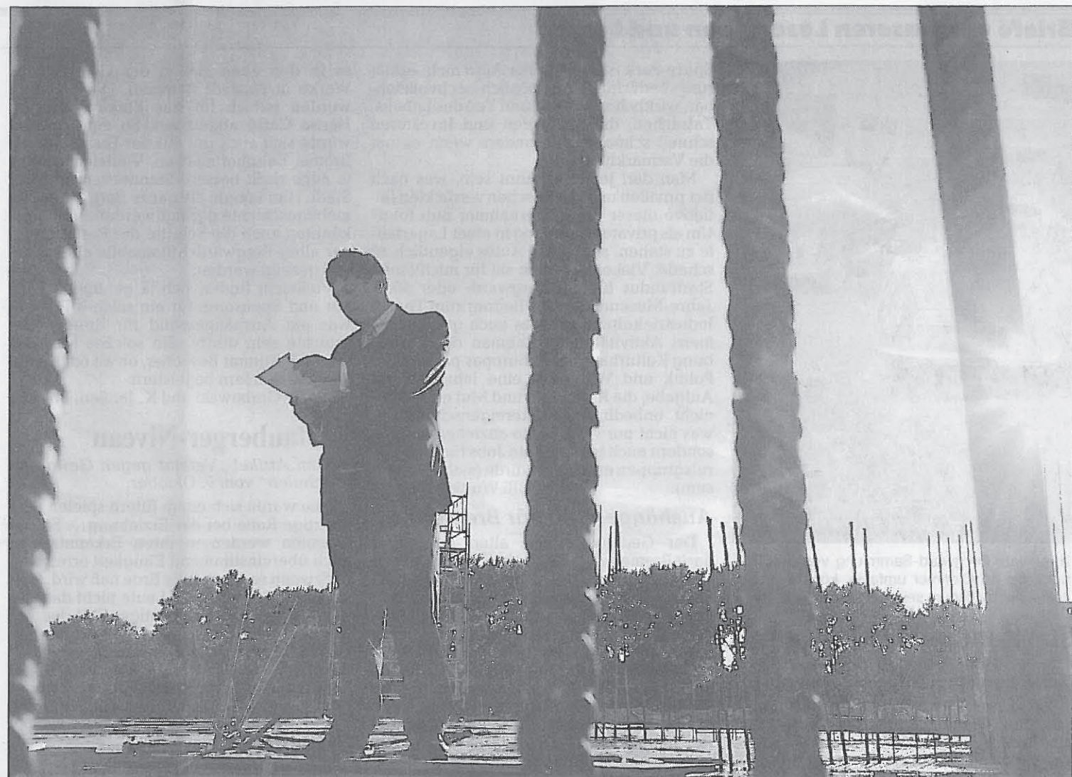
Alles im Lot? Der Bauherr auf seiner von der Sonne beschienenen Baustelle.
