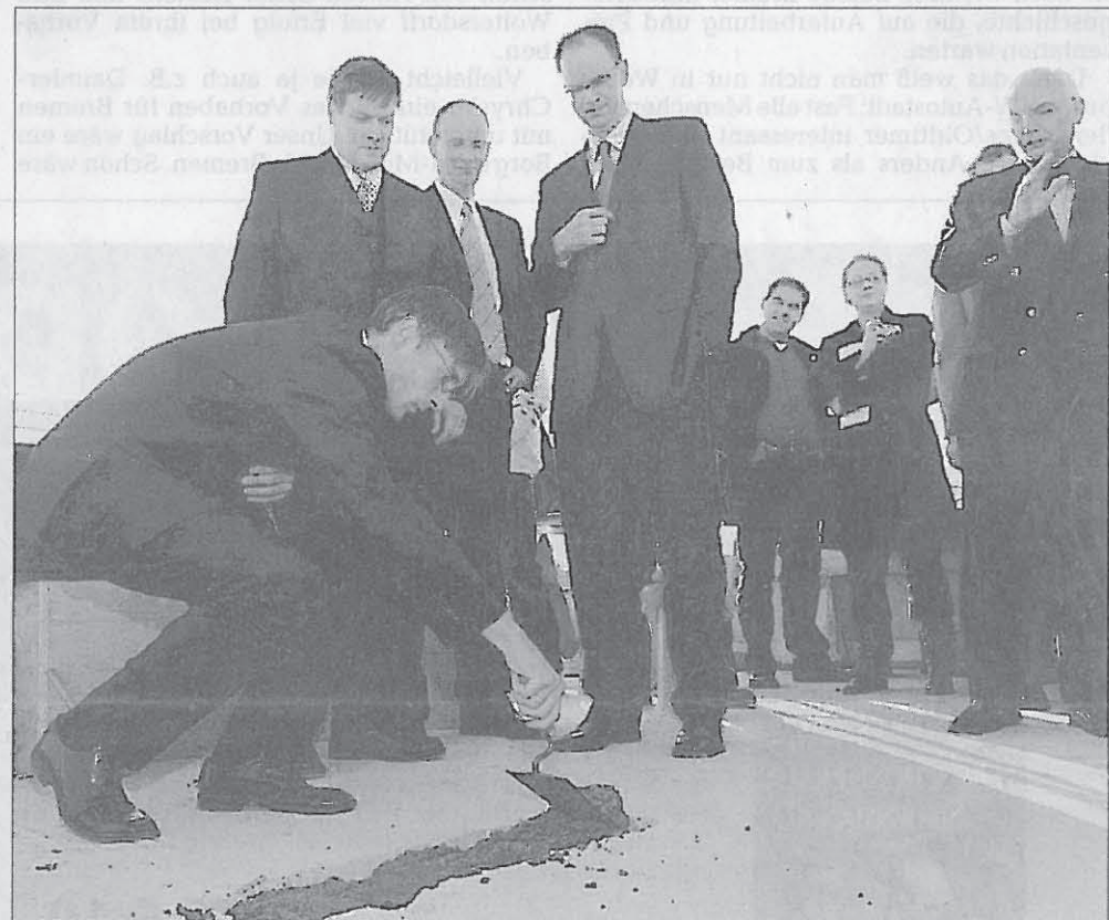
Mit Anzug und Maurerkelle hat sich die Festgesellschaft zur Grundsteinlegung eingefunden.
